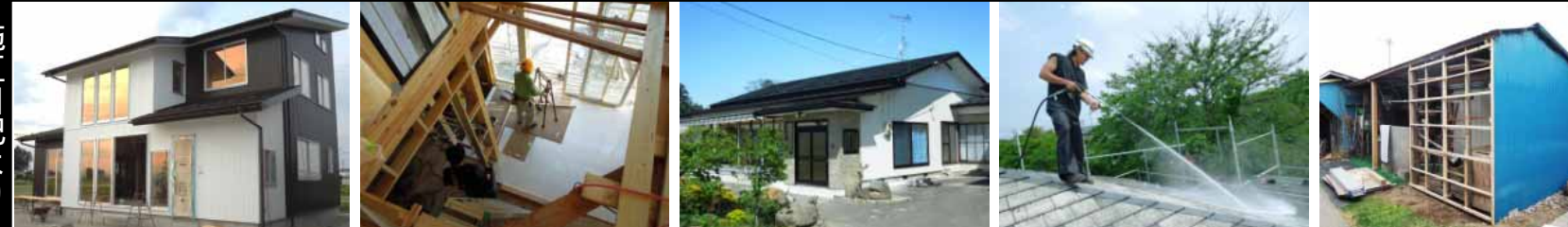
[美里町住宅新築工事]
